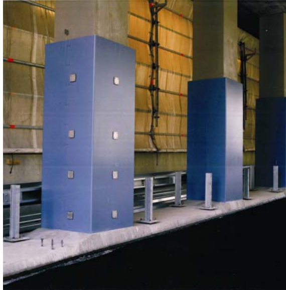
Bild 3.3: Versuchsstütze nach der Instandsetzung: Öffnungen im Stahlmantel für die Potenzialmessung.
